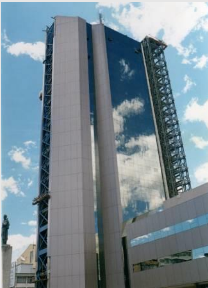
FACHADA EN VIDRIO TEMPLADO , ALUCOBOND Y VENTANERÍA EN SILICONA ESTRUCTURAL 6800 m 2
